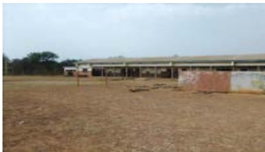
Vue de l'école primaire de N'gbanhala
