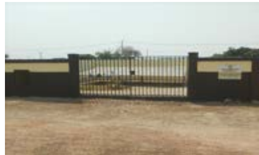
Vue du forage
