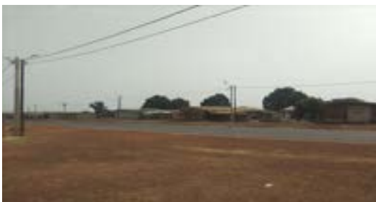
Vue d'équipement et infrastructure de N'gbanhala
