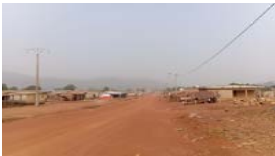
vue du réseau électrique de Blapleu
