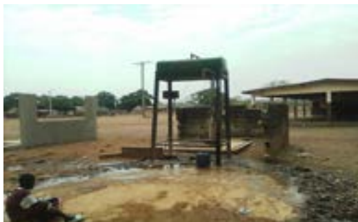
Vue de la pompe de l'école primaire de Kimbirila
