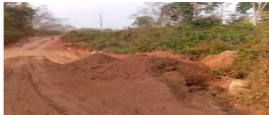
Vue de la voie de Dio en cours de reprofilage
