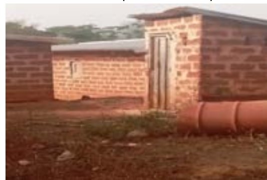
Vue de bâtiment en geobeton
