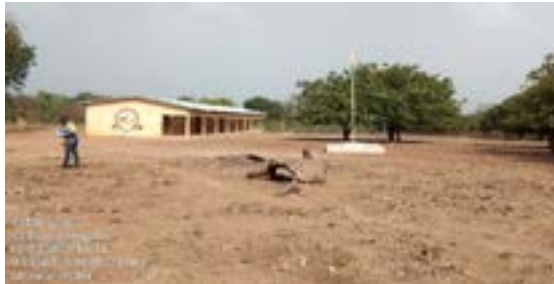
Vue du Collège Moderne de Fengolo
