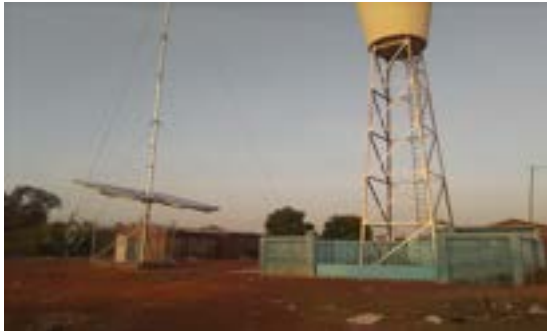
Vue du château d'eau
