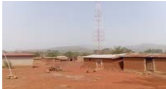
Vue d'une antenne de téléphonie mobile et de bâtis en géo béton
