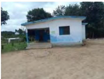
Vue de la maternité construite
