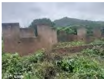
Photo 1 : Vue du centre de santé de Boudi en construction
