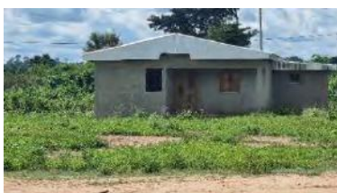
Vue du logement de l'infirmier en construction
