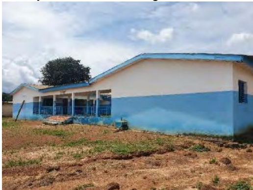
Maternité : vue d'ensemble du bâtiment
