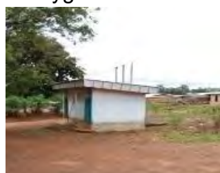
Latrines du CSR
