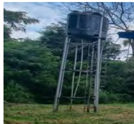
Réservoir d'eau du CSR
