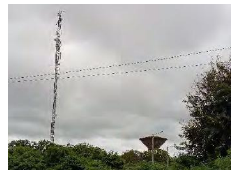
Equipement hydraulique et électrique
