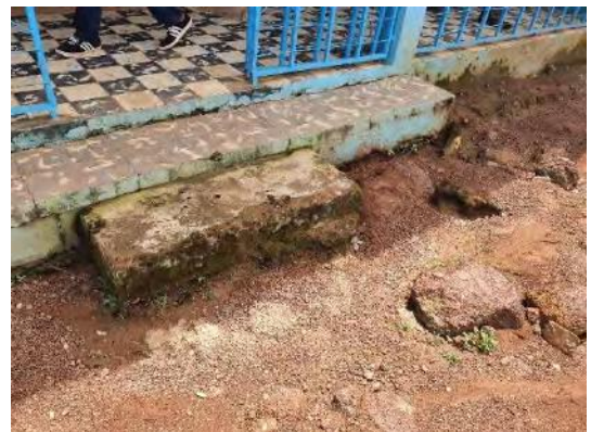
Dispensaire : Marches d'escaliers à l'entrée du bâtiment
